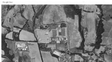
vista zona Industriale da Google con in evidenza il fabbricato
